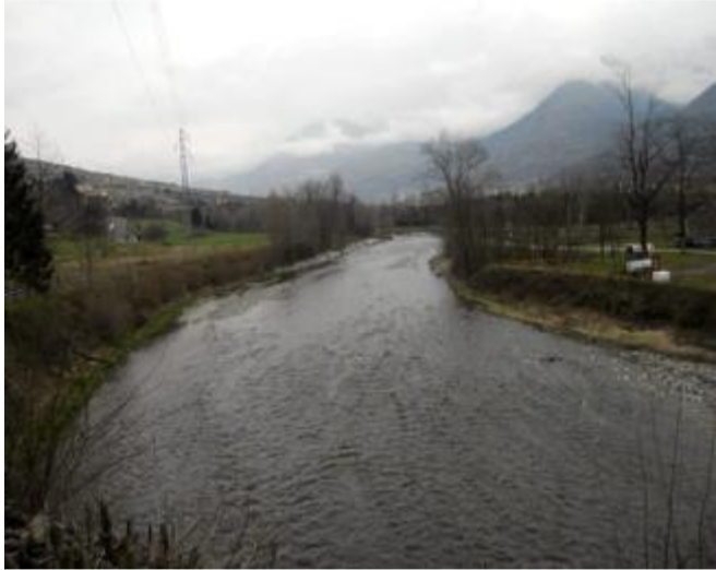
Saranno le acque del fiume Oglio ad alimentare la nuova centralina
